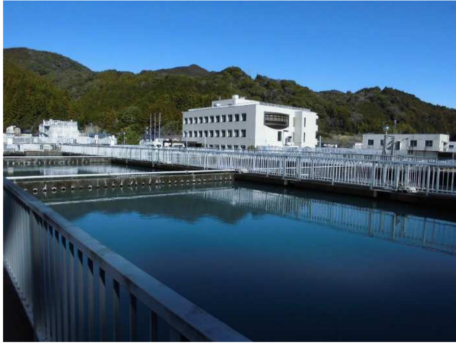
相賀浄水場（大井川広域水道企業団）
