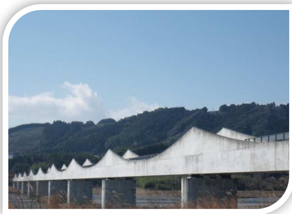
大井川水路橋（大井川右岸土地改良区）
