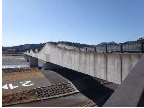
【大井川水路橋】
