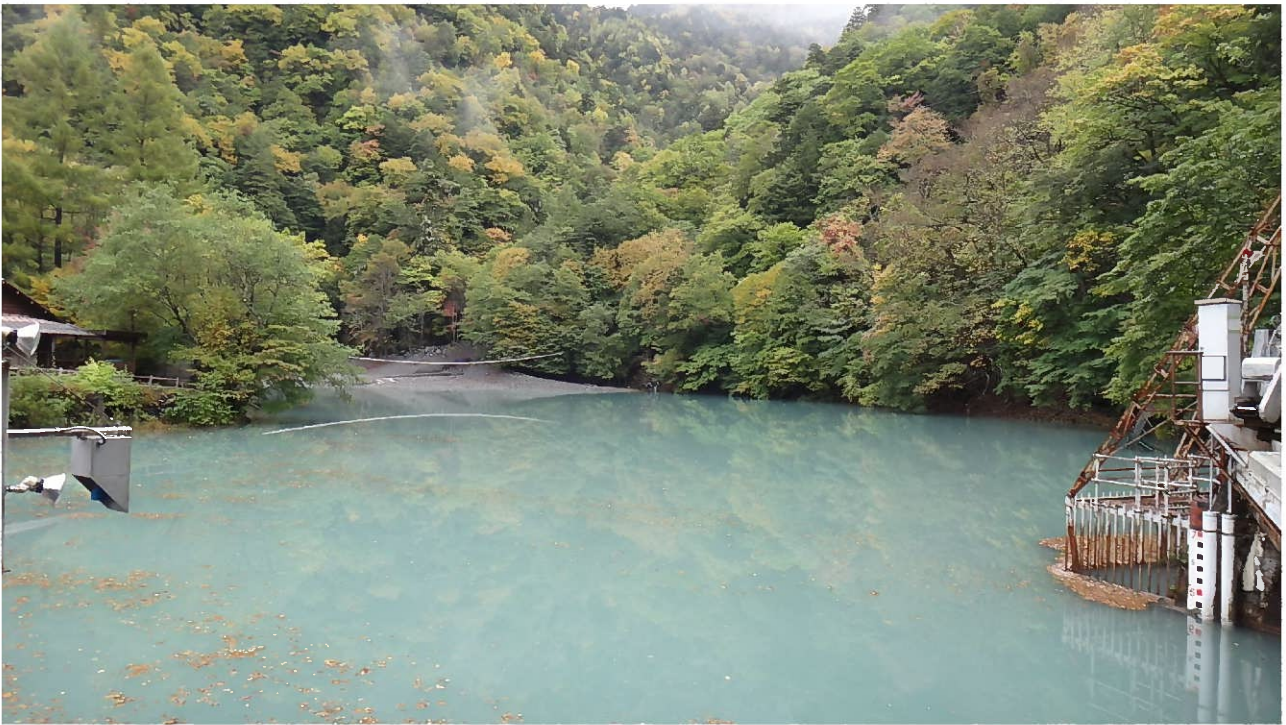
田代ダムから、大井川より取水された水が流れ込む方向を望む
